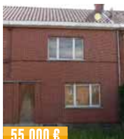
PLACE DE LA RÉPUBLIQUE, 4 – LEERNES 2 chambres (à rénover)
